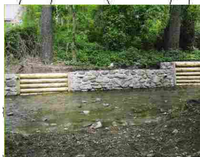
Využitie vodného toku v obci - úprava premostenia a spevnenie brehu vodného toku
