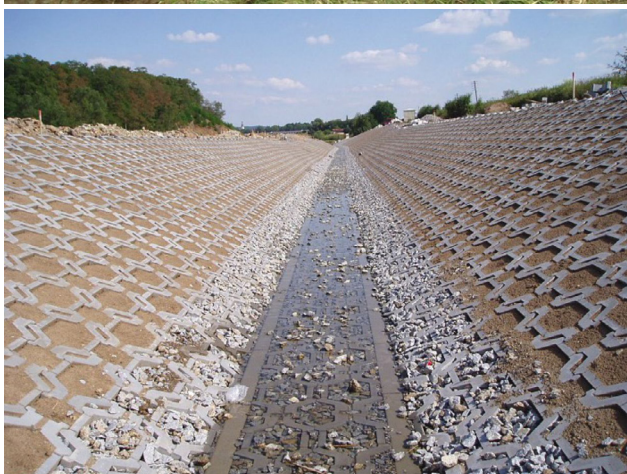
Betónové prefabrikáty – trávovo-betónové opevnenie brehov vodných tokov
