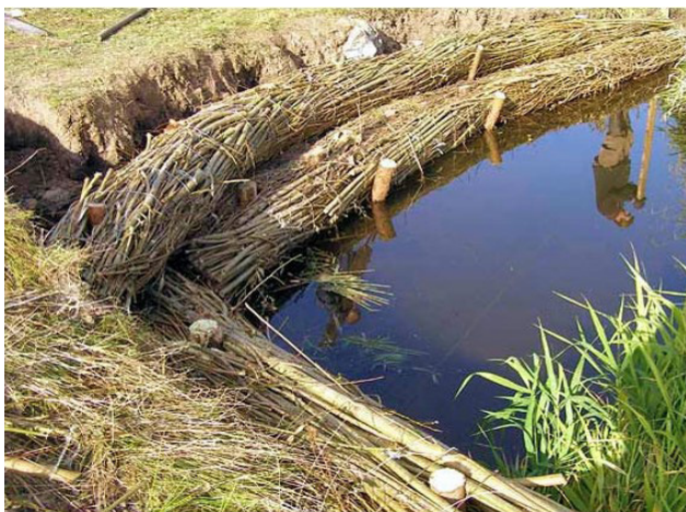
Obklady svahov vodných tokov vrbovým prútím
